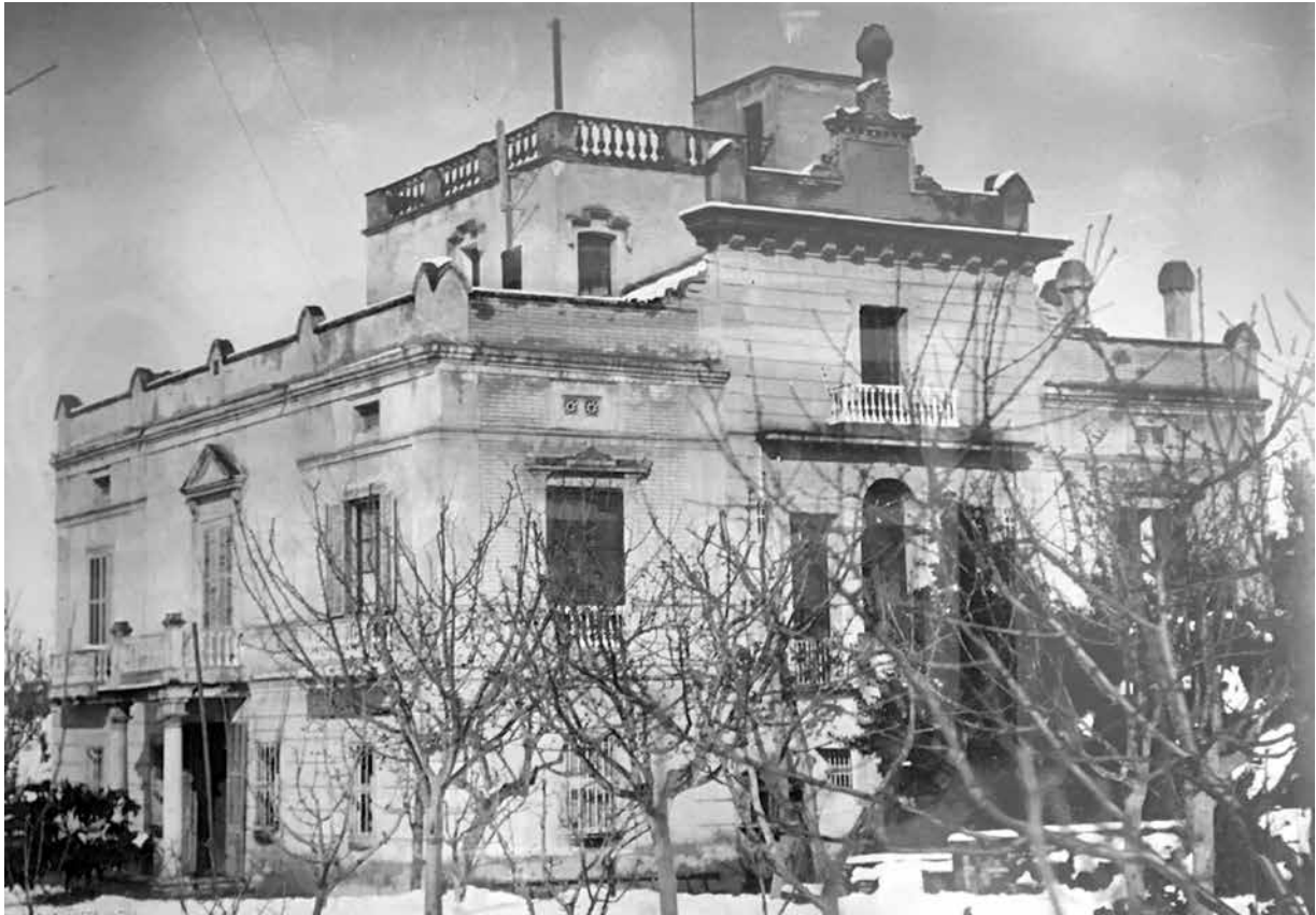
Casa de Pau Muntadas, a Igualada. Avui coneguda com la torre de ca l'Artés
