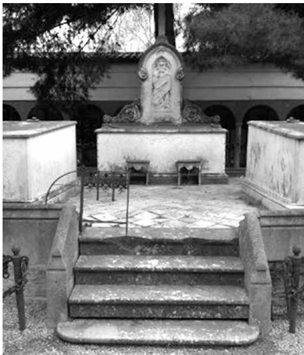
Estat actual del panteó
