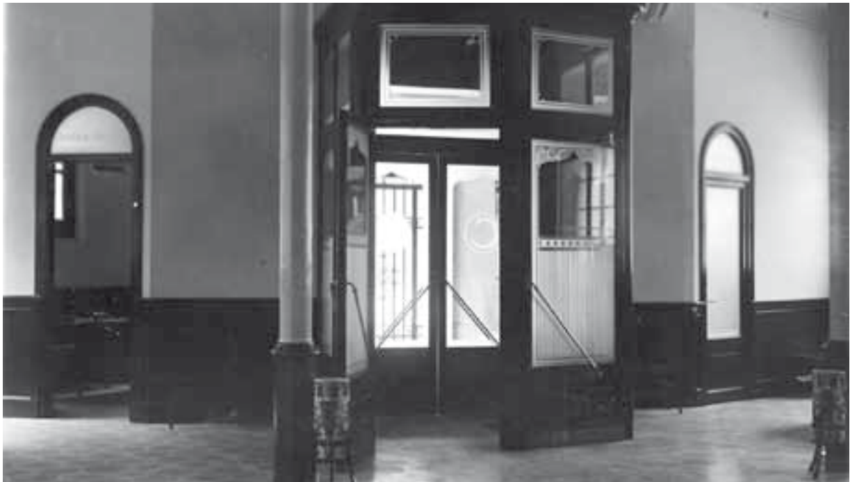
Foto 7: Porta d'accés a les oficines de la nova seu de la sucursal de «la Caixa» Font: Arxiu de «la Caixa»
