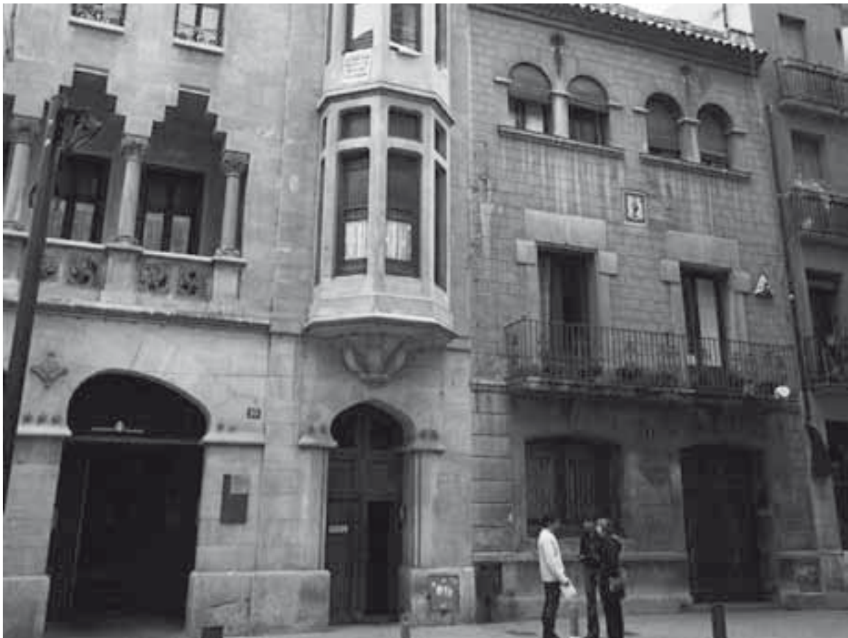
Façana actual. Carrer de Santa Maria, 8
